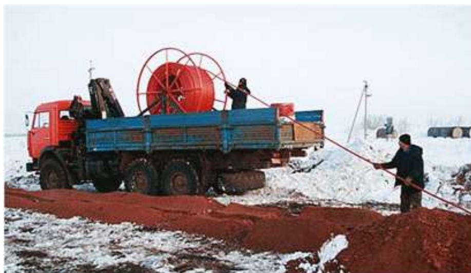
Рисунок 2 – Пример прокладки ЧЭ в траншею
